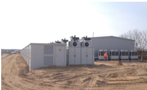
Letzte Bauarbeiten zur Vollendung des Batteriespeicherprojekt EnspireMe im April 2018.
