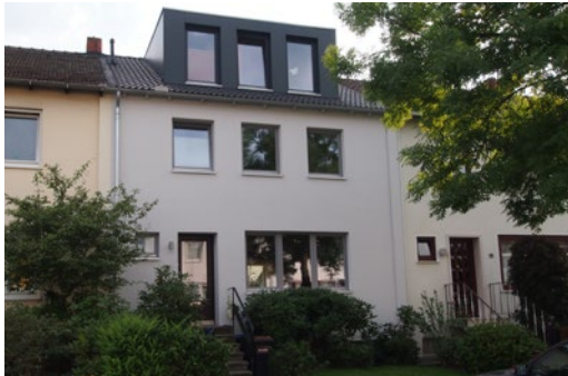
Das "Modernisierungsobjekt des Jahres 2014": Ein saniertes Reihemittelhauses Baujahr 1962 mit Dachausbau in Bremen-Schwachhausen
